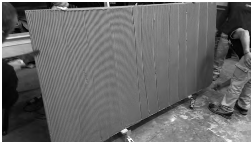
Eseguire delle strisce e non delle curve
